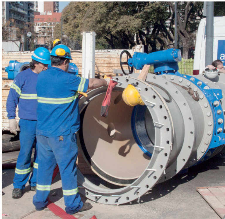
Cambio de manos. AySA se trata de la mayor privatización de la era Milei.
