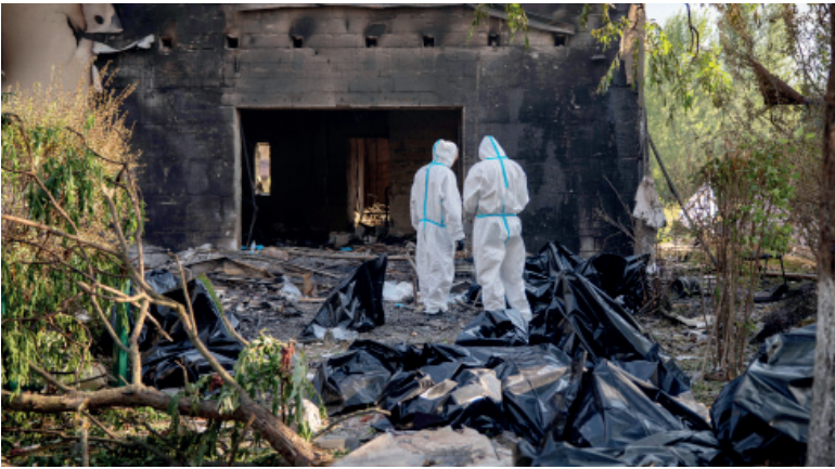
Daños. Unas 400 personas fueron evacuadas y medio centenar de viviendas resultaron dañadas.
