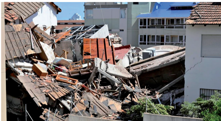
El derrumbe. Del Apart Hotel Dubrovnik en Villa Gesell
