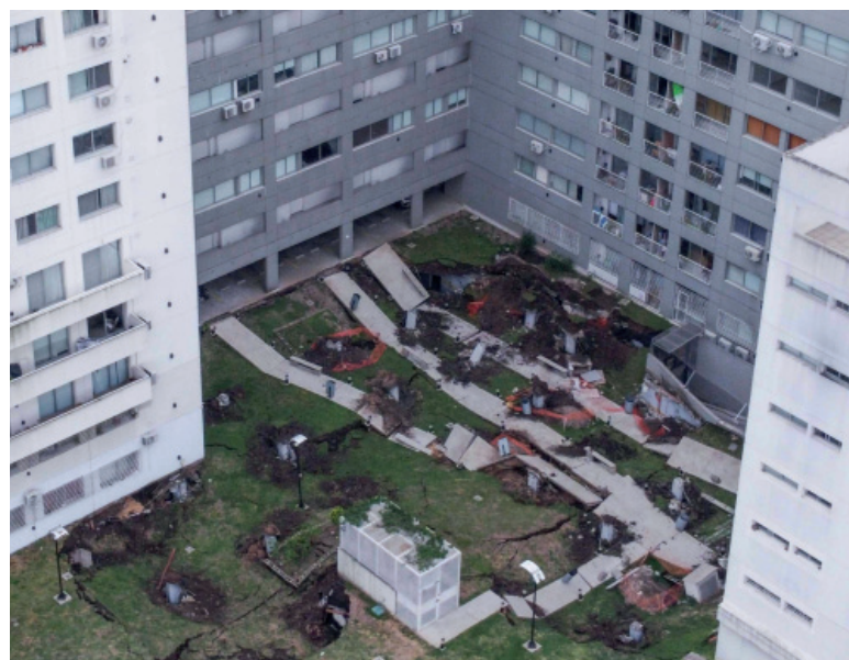
"Estrago". Vista aérea del techo derrumbado. - NA -
