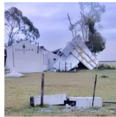
Una escuela terminó destruida en el partido de Cañuelas.
