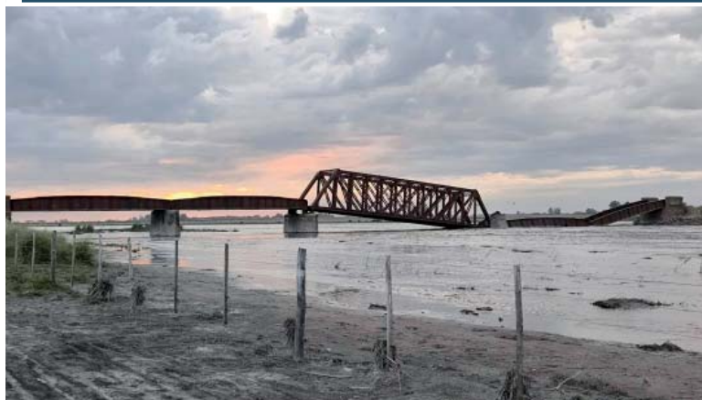
En medio de las inundaciones que afectan a gran parte de la provincia de Buenos Aires, y mientras rige una alerta por tormentas en el territorio bonaerense para el fin de semana, un antiguo puente ferroviario ubicado entre Chivilcoy y 25 de Mayo se derrumbó sobre el río Salado.
