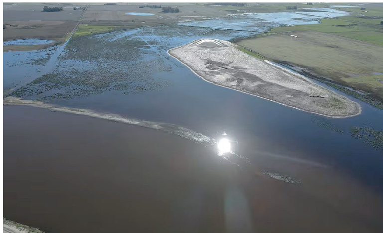
Reclamo. Carbap viene alertando, además, sobre la paralización de las obras del Plan Maestro del Salado.
