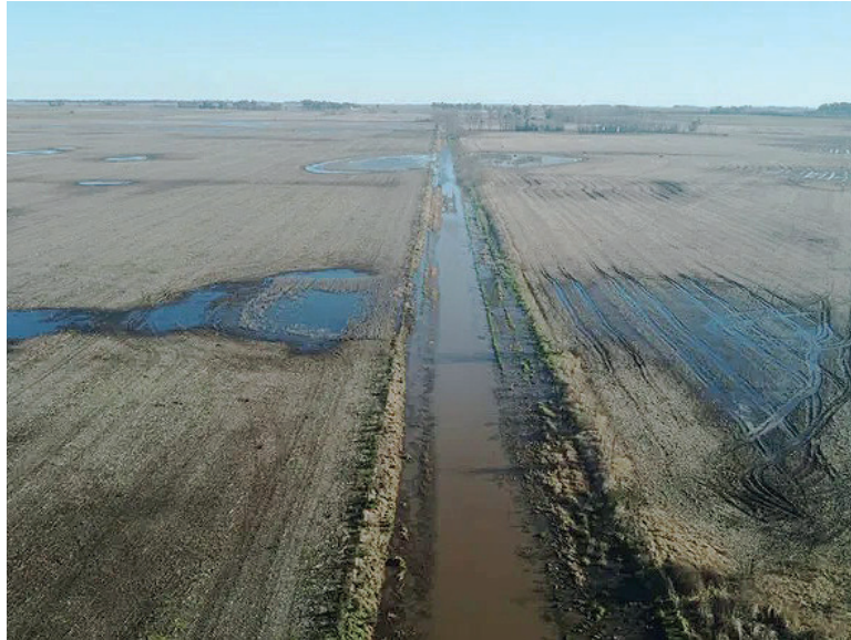
Paralizadas. Faltan obras para mitigar las inundaciones que afectan a miles de hectáreas de la provincia.
